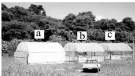
Figura 3: Três galpões com diferentes coberturas plásticas de polietileno nas cores branca, transparente e verde. Com pilares de madeira e estrutura do telhado com tubo metálico. Dentro de cada galpão foram colocadas três caixas de fibrocimento (TEODORO et al., 2005).
