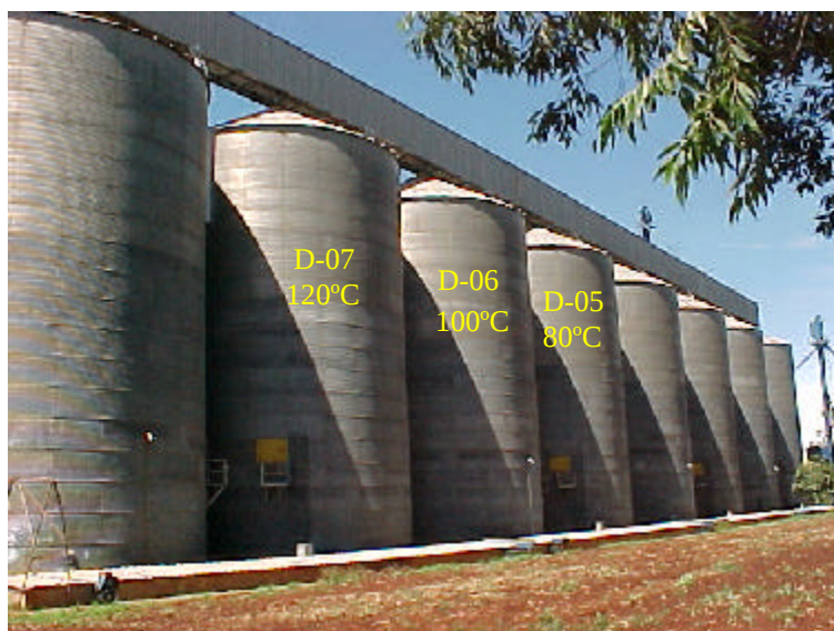
Figura 9 – Silos metálicos utilizados para armazenagem de milho.
