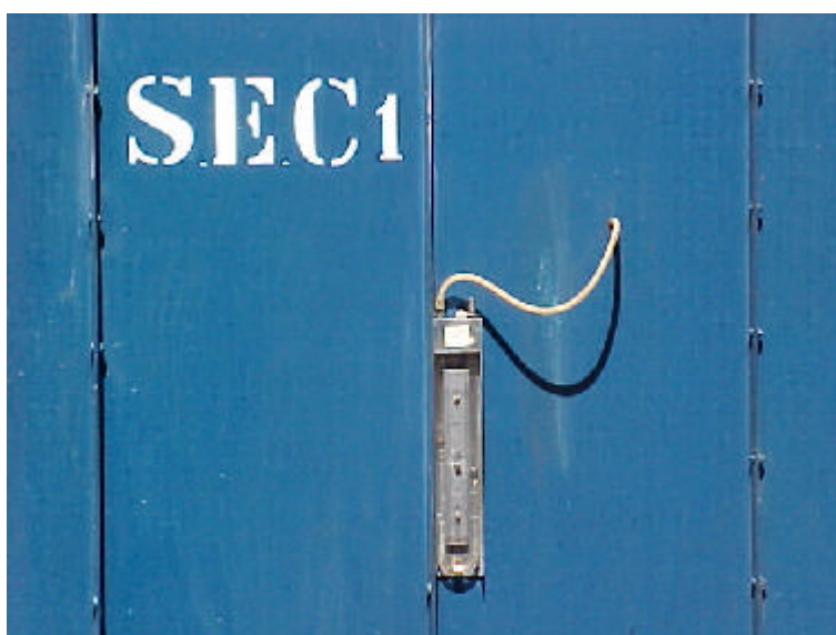
Figura 6 – Manômetro para medição da pressão estática no secador.
