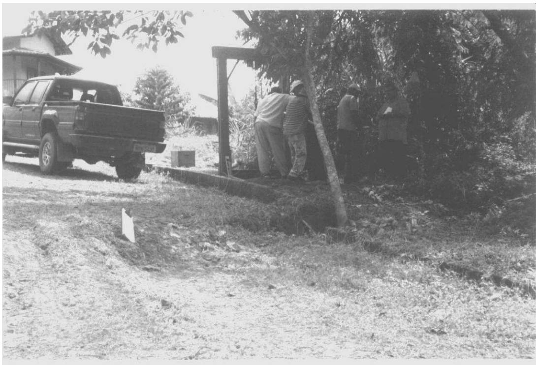
- Figura 46, cunha de ruptura junto à seção geotécnica B.
