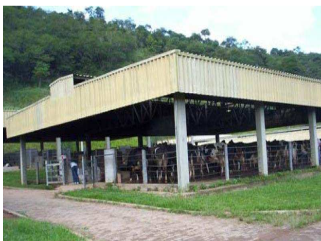
Foto 4 – Instalação onde foi executado o experimento.
