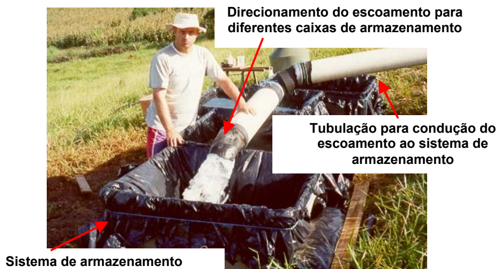
Figura 23. Representação do sistema de armazenamento do escoamento.
