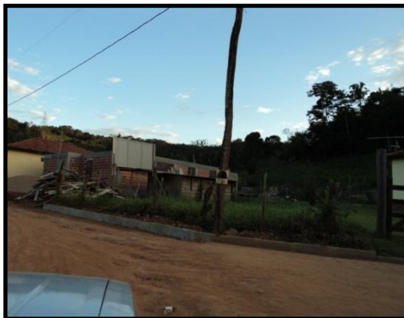
Figura 7- Construção do novo posto de saúde Fonte: Pesquisa de campo, 2012.
