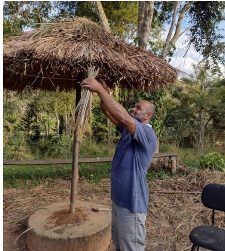
Foto 14 - Construção de cobertura de sapé para o ponto de prosa.
