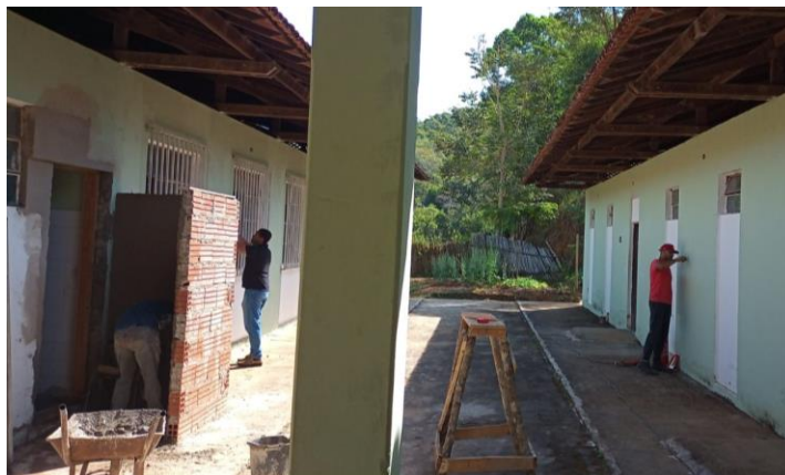
Foto 15 - restauração da parte externa e construção de banheiro.
