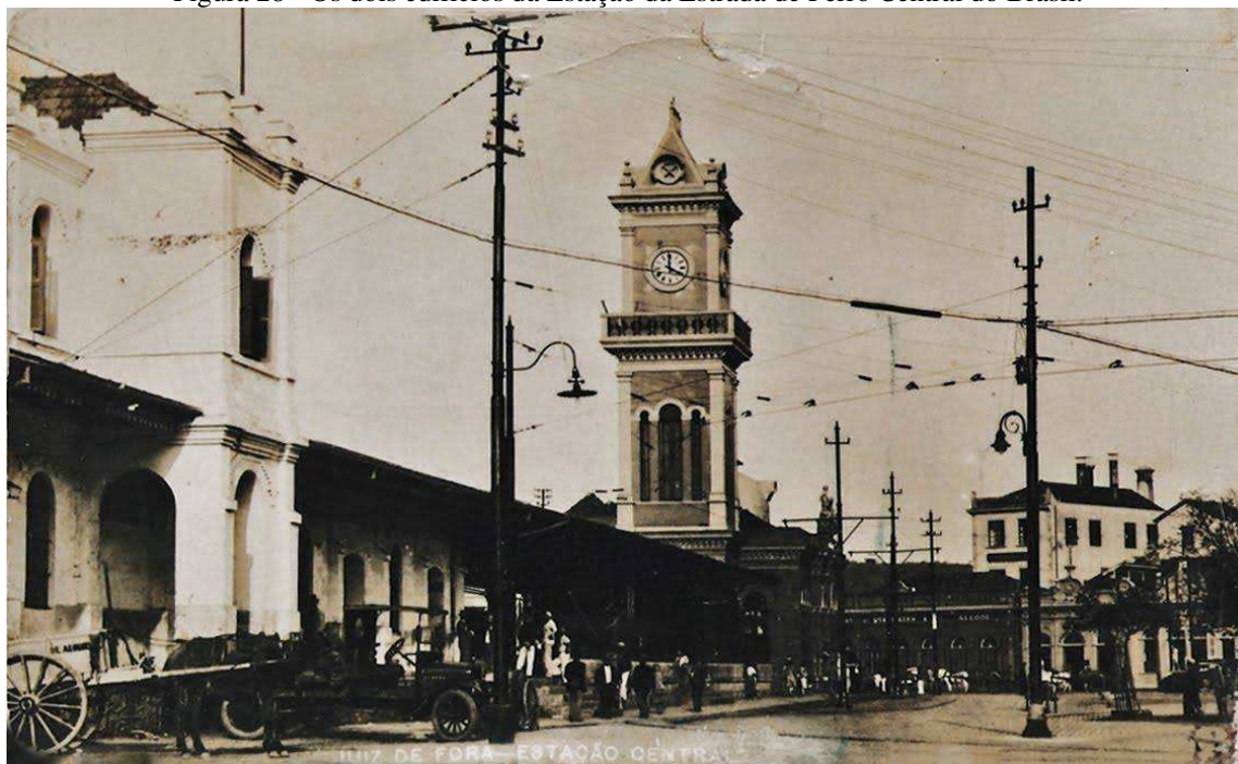
Figura 28 - Os dois edifícios da Estação da Estrada de Ferro Central do Brasil.
