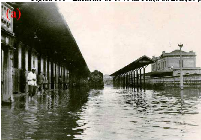
Figura 36c - Enchente de 1940 na Praça da Estação próximo à ponte da E. F. Central do Brasil.
