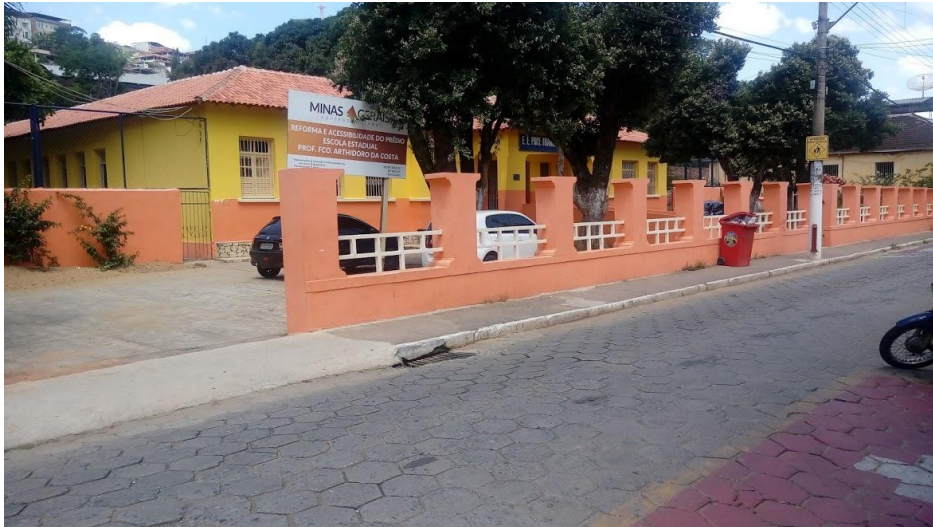
Figura 9: Fachada da Escola A
