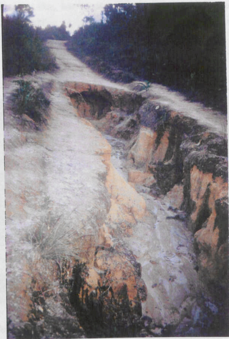
Figura 11 - Parte do percurso da trilha da Cascatinha que apresenta estágios avançados de erosão.
