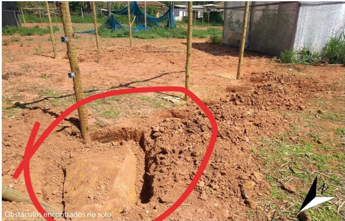
Figura 27 - Obstáculos encontrados e perfuração do solo
