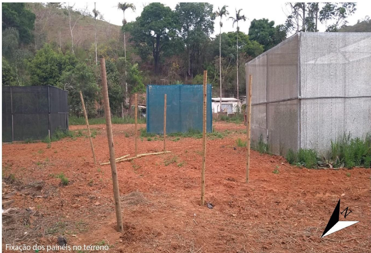
Figura 26 - Fixação e construção dos painéis
