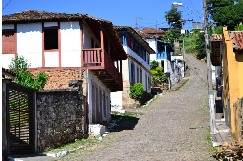
Figura 9 - Rua do Rosário (iniciando com a Casa de Paulo Josafá, hoje restaurada e atual sede da SEMCULT)
