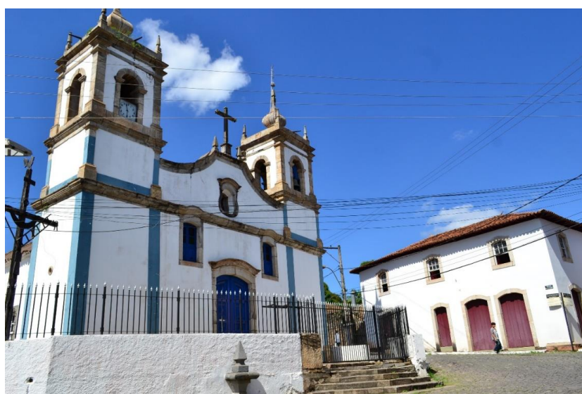
Figura 8 - Igreja Nossa Senhora de Boa Viagem e entorno - Itabirito, Minas Gerais
