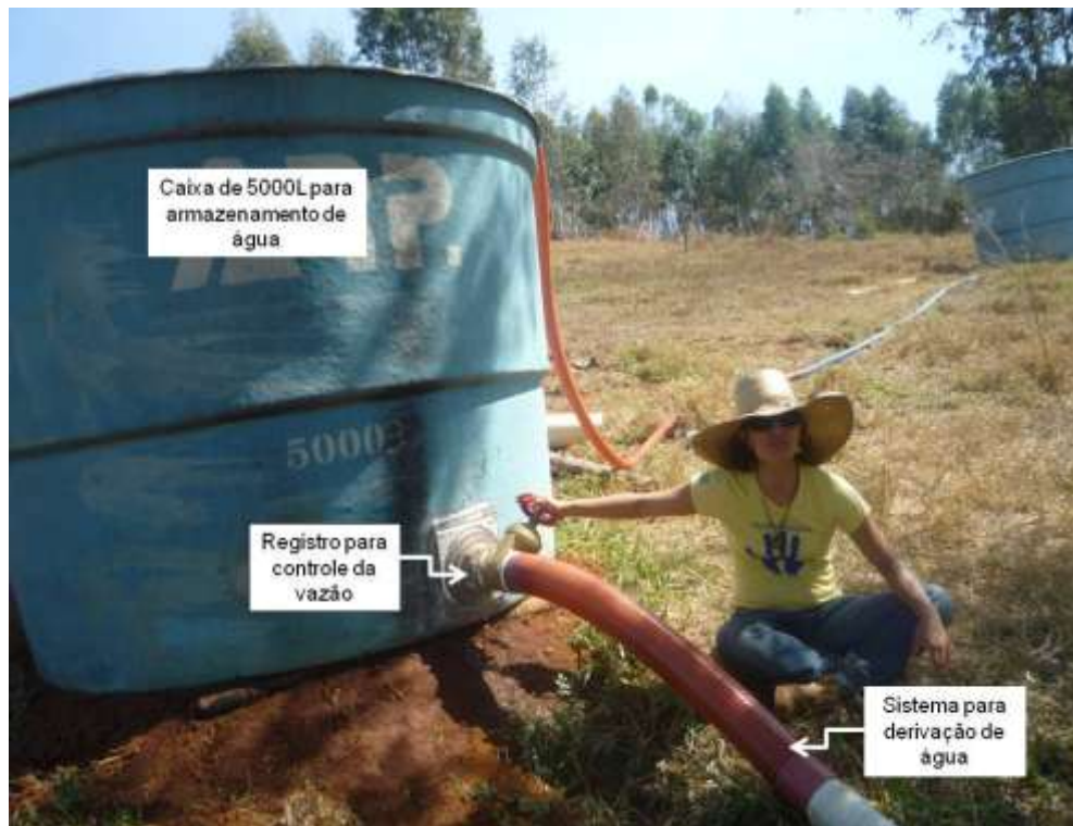
Figura 7 - Sistema de armazenamento e derivação de água.
