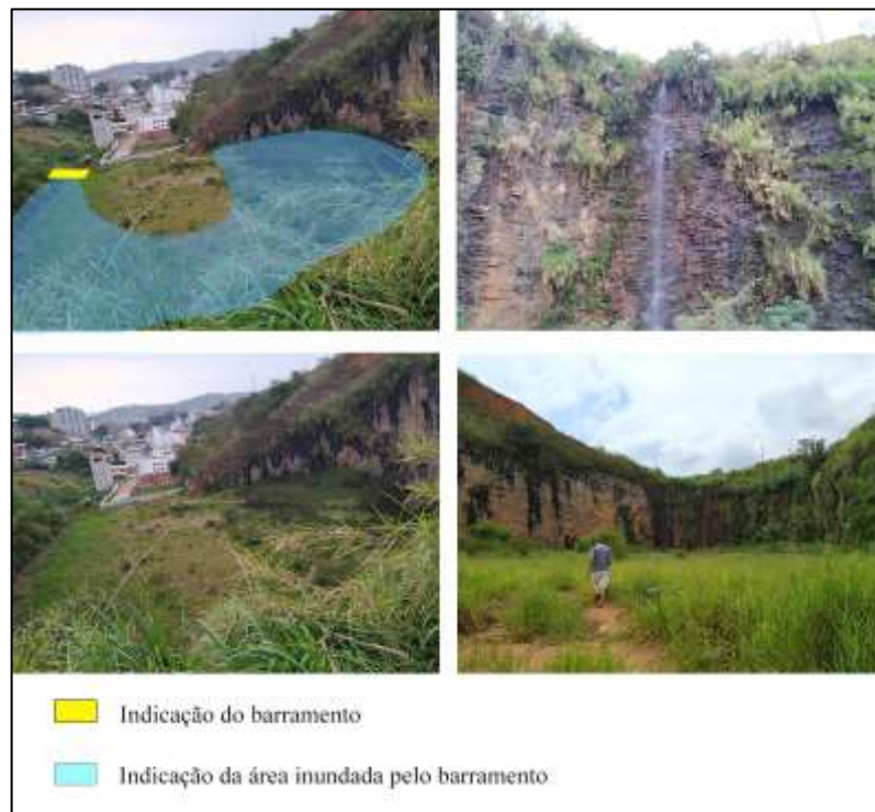
Figura 9 - Fotos da lavra da pedreira inativa, onde foi sugerido a construção do barramento de retenção
