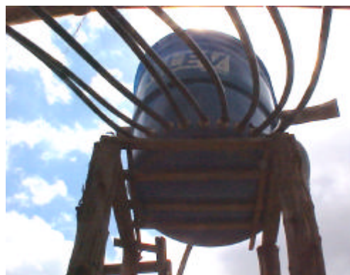
Figura 11: Detalhe do sistema de distribuição, por gravidade, de ARS para os filtros orgânicos.
