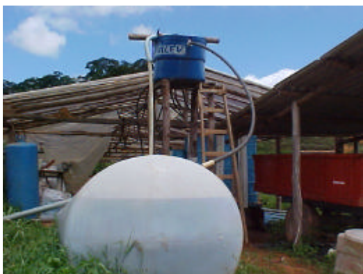
Figura 10: Reservatório de estocagem usado para alimentar a caixa de distribuição de ARS para os filtros.
