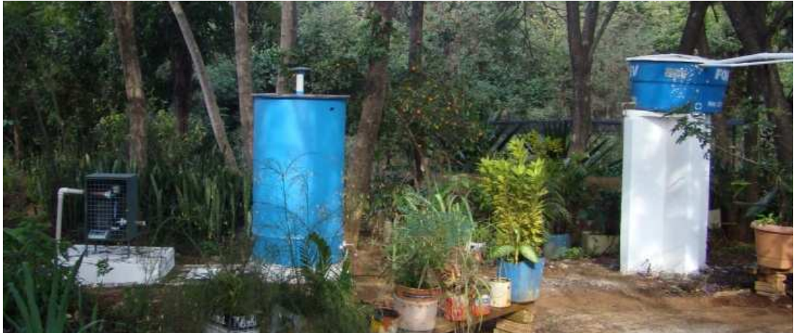
Figura 4 – Sistema de reuso de água cinza
