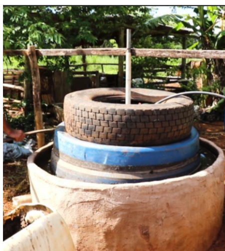
Figura 9 - Biodigestor instalado na zona rural de Três Lagoas (MS)
