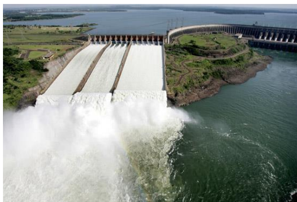
Figura 5 - Vertedouro da Usina Hidrelétrica de Itaipu, em Foz do Iguaçu (PR)
