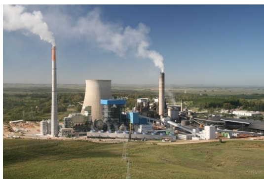
Figura 10 - Imagem da usina termelétrica em Candiota (RS)
