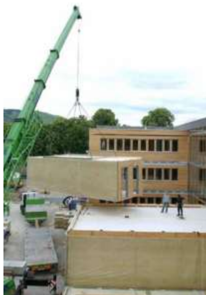
Figura 4 – Montagem dos blocos de um prédio na cidade de Graz, Áustria
