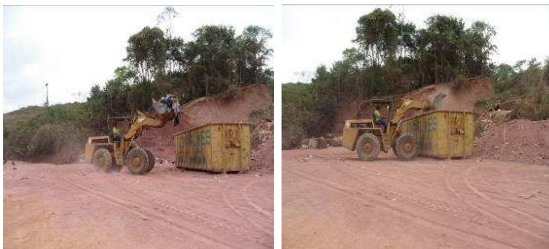
Figura 14 - Caçamba coletora dos resíduos gerados em Matias Barbosa
