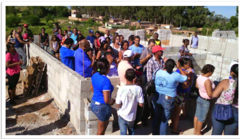
Segunda visita dos beneficiários as obras do Residencial Dom Luciano. 18/01/2015.
