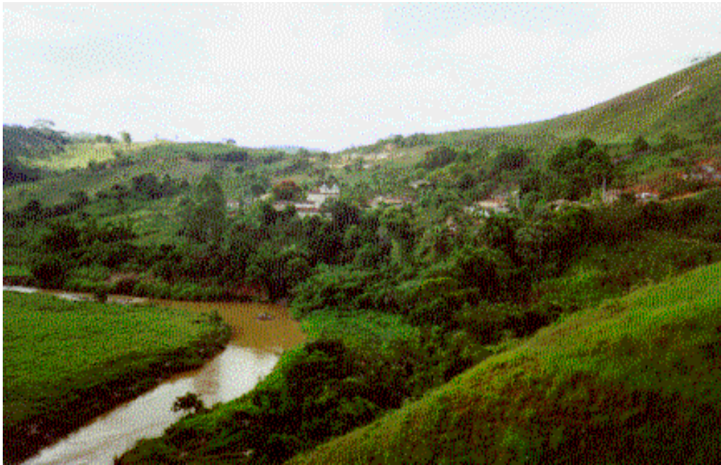
Figura 3B - Vista parcial do povoado de Miguel Rodrigues.
