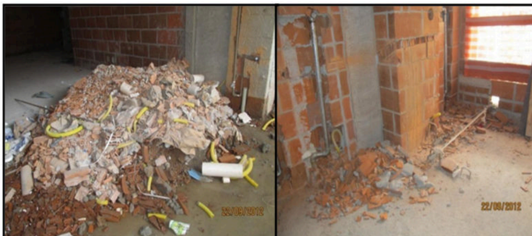
Figura 1 - Exemplos de geração de RCC na fase de execução de alvenaria
