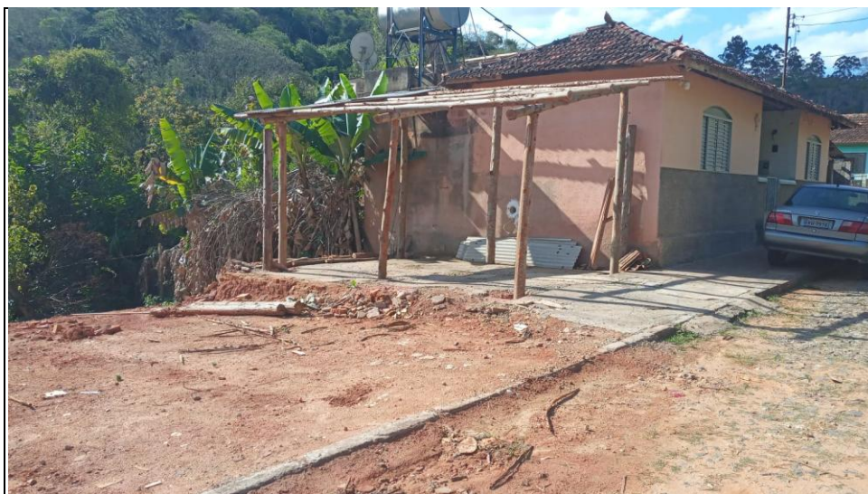
Figura 49 - Casa demolida Vila Secundino
