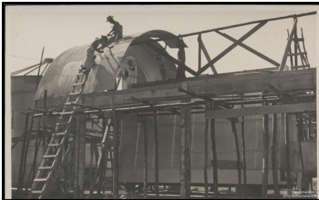
Figura 13 - Instalação dos Silos no Vale da Agronomia - UREMG
