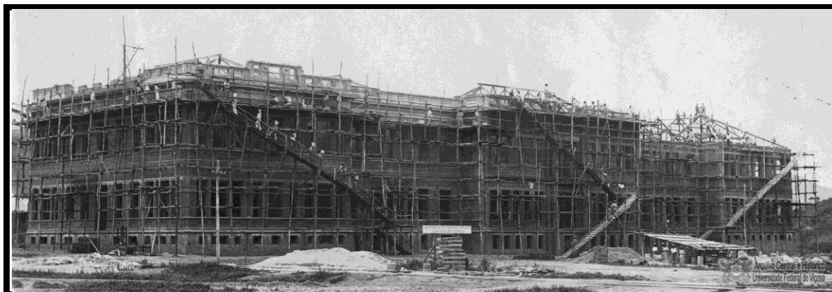
Figura 34 - Prédio Principal em construção - Década de 1920
