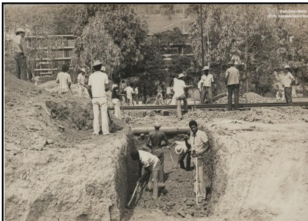
Figura 10 - Obras de saneamento
