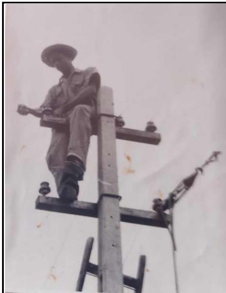
Figura 17 - Instalação de energia na Vila Giannetti - Década 1950
