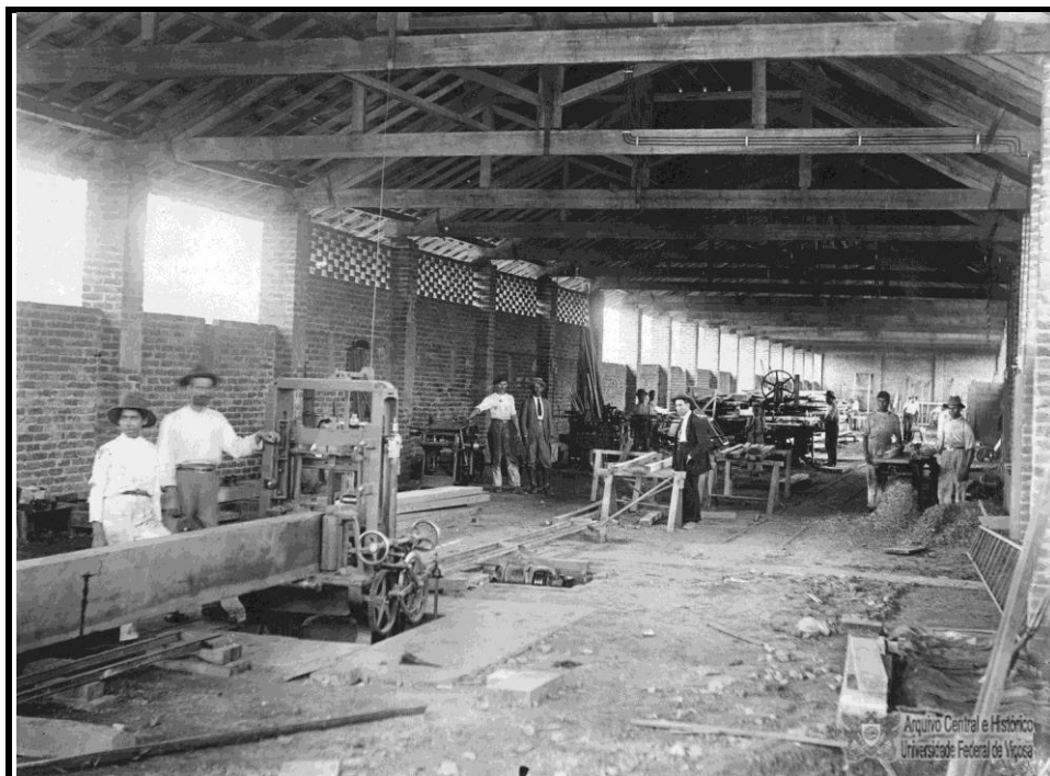
Figura 35 - Vista interna do galpão das oficinas - 1925
