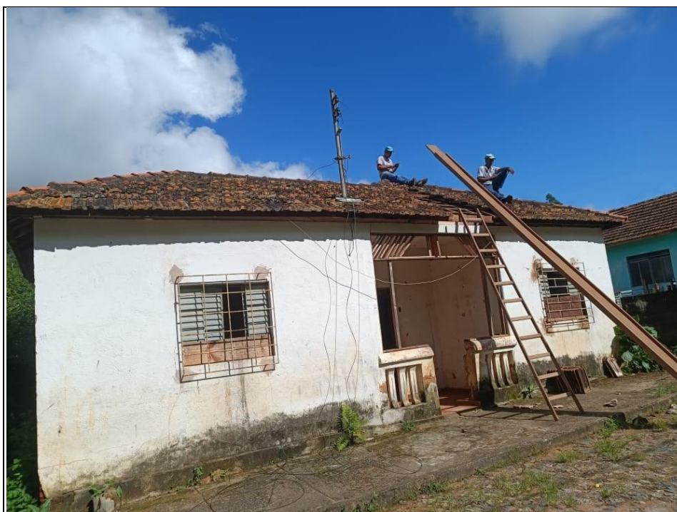
Figura 50 - Processo de demolição - Vila Secundino
