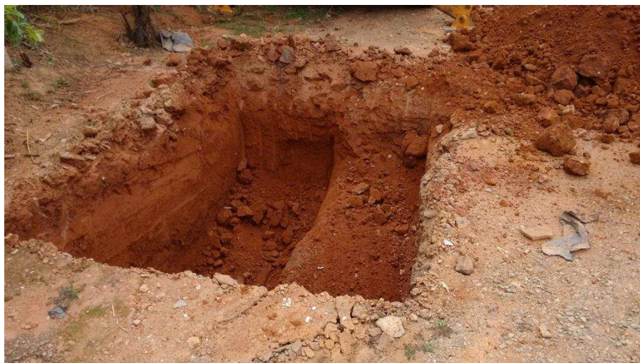
Figura 3.23 - Abertura da trincheira em dois patamares.
