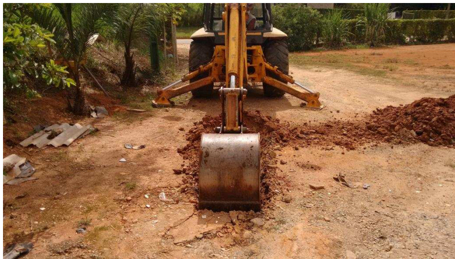
Figura 3.22 - Retroescavadeira utilizada na abertura da trincheira.
