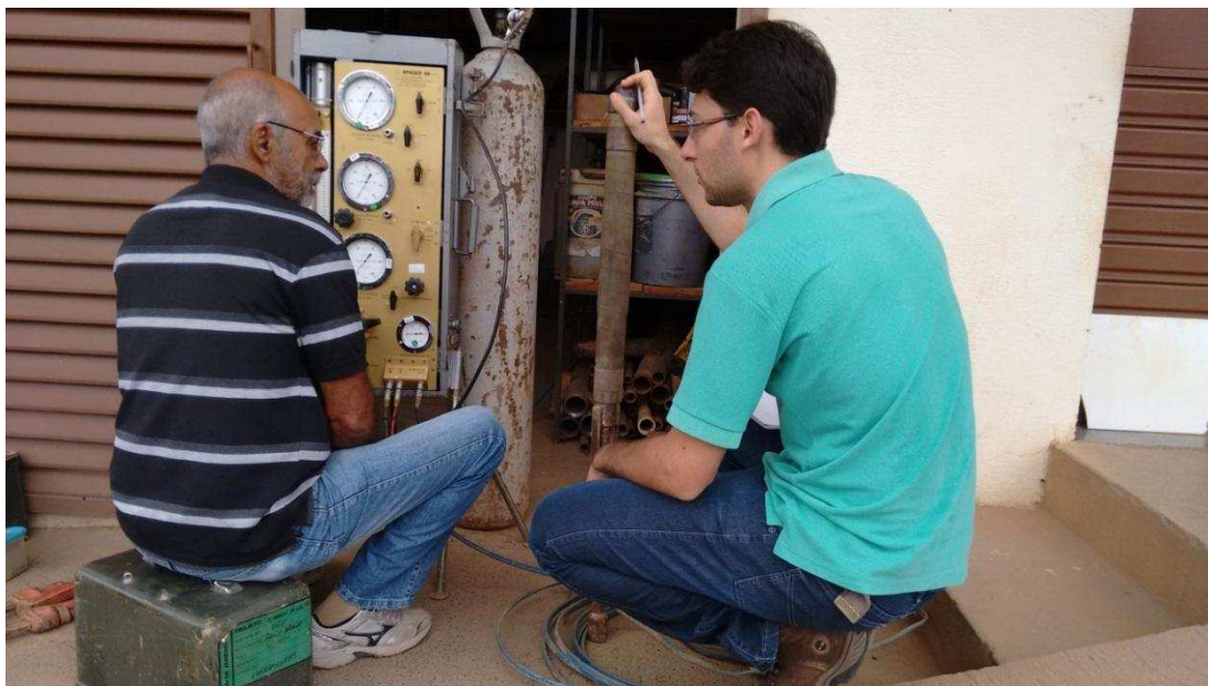
Figura 3.12 - Posicionamento da sonda para calibração por perda de pressão.
