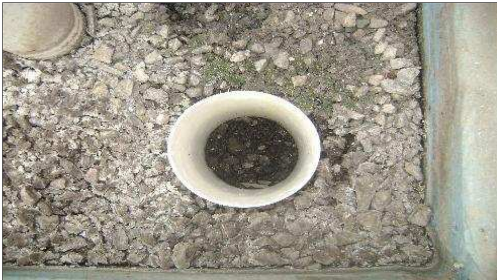
Figura 6: Vista, em planta, do tubo de PVC cravado no leito do SAC-EHSS, onde se coletava o material colmatante.
