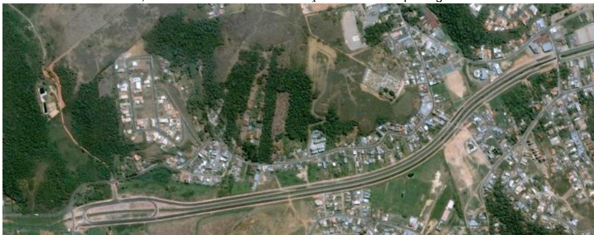
Figura 15: Imagem de satélite de 2005 registra o avanço das obras do primeiro trecho da Via São Pedro, evidenciando as transformações iniciais na paisagem local.
