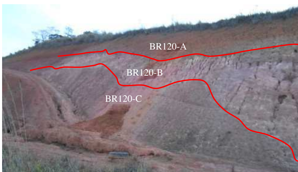
Figura 16 – Corte rodoviário em perfil de solos residuais selecionado para o estudo.
