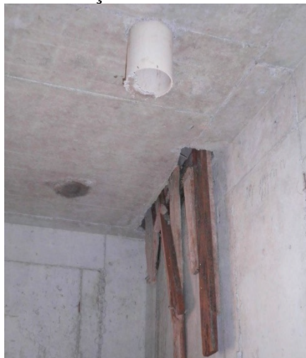
Figura 13: Instalação hidráulica embutida. Fonte: autora.
