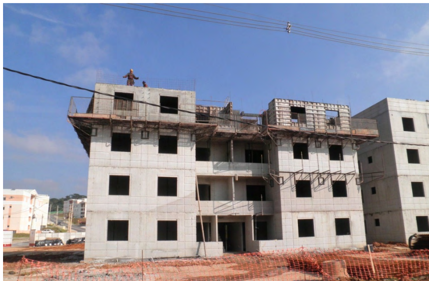
Figura 11: Sistema construtivo moldado in loco , fase 7. Fonte: autora.
