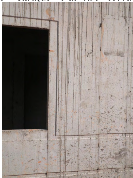
Figura 14: Detalhes de fachada moldados pela forma construtiva. Fonte: autora.
