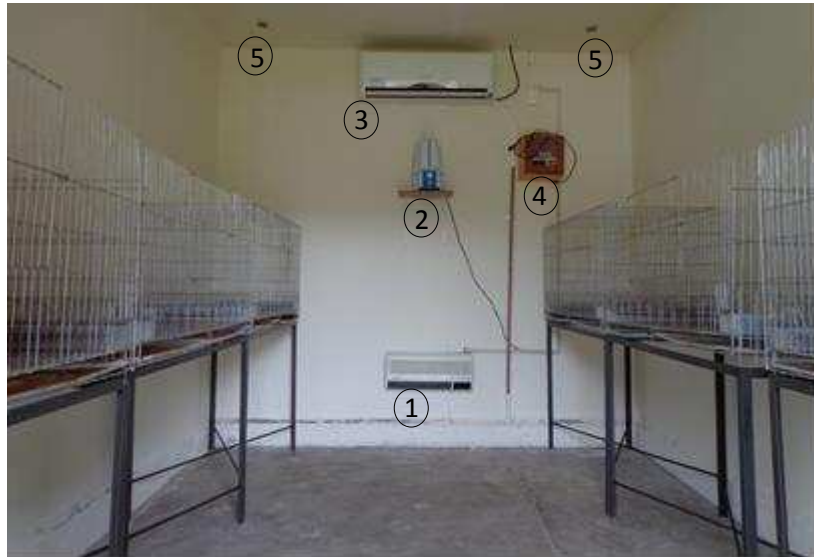
Figura 3.1 – Vista interna das câmaras climáticas com destaque para os equipamentos utilizados para o acondicionamento térmico do ambiente: 1 – Aquecedor; 2 – Umidificador; 3 ar condicionado; 4 – Controlador eletrônico; 5 - Exaustores.
