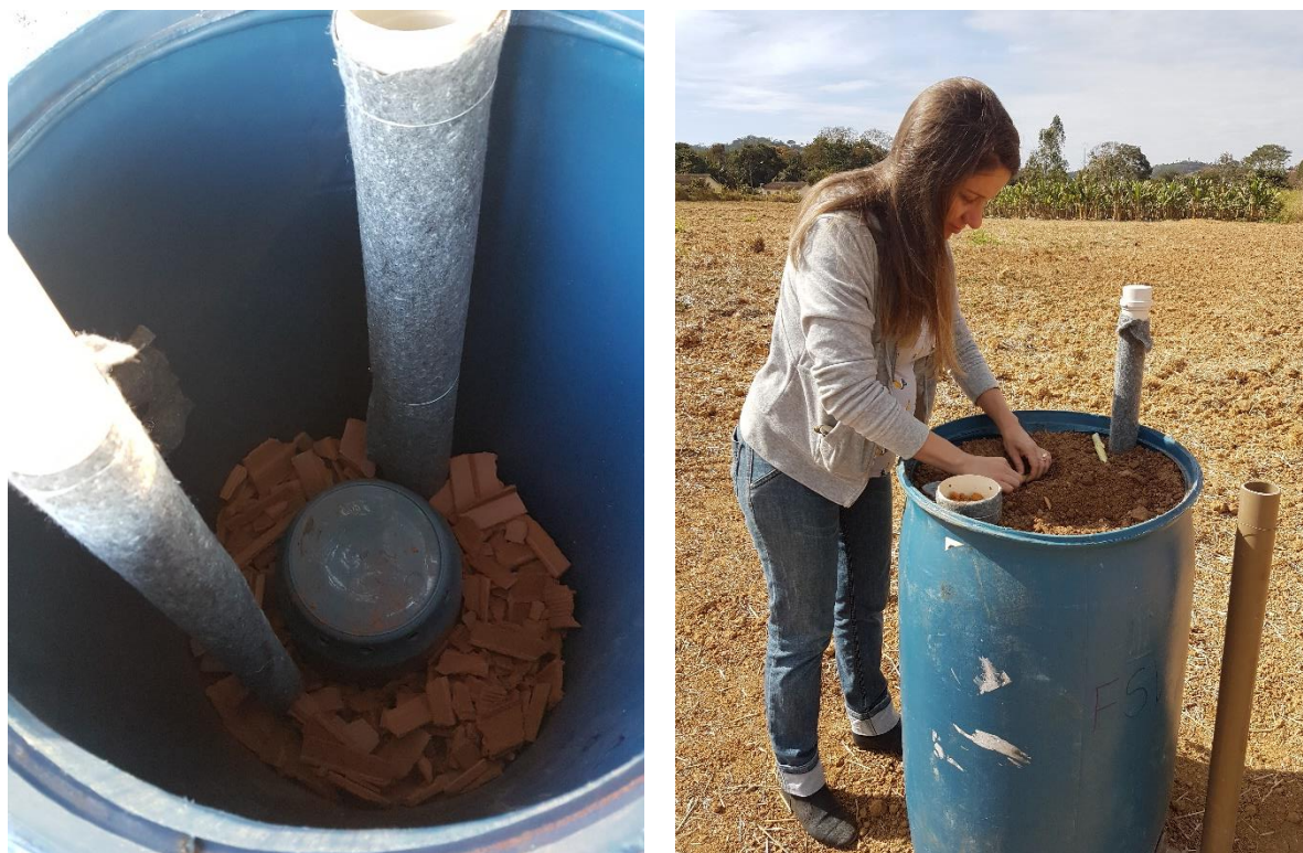
Figura 1 – Montagem de um tanque de evapotranspiração (TEvap) com destaque para a câmara anaeróbia e plantio das mudas na última camada. Rio Pomba – MG, 2019. Fonte: a autora.
