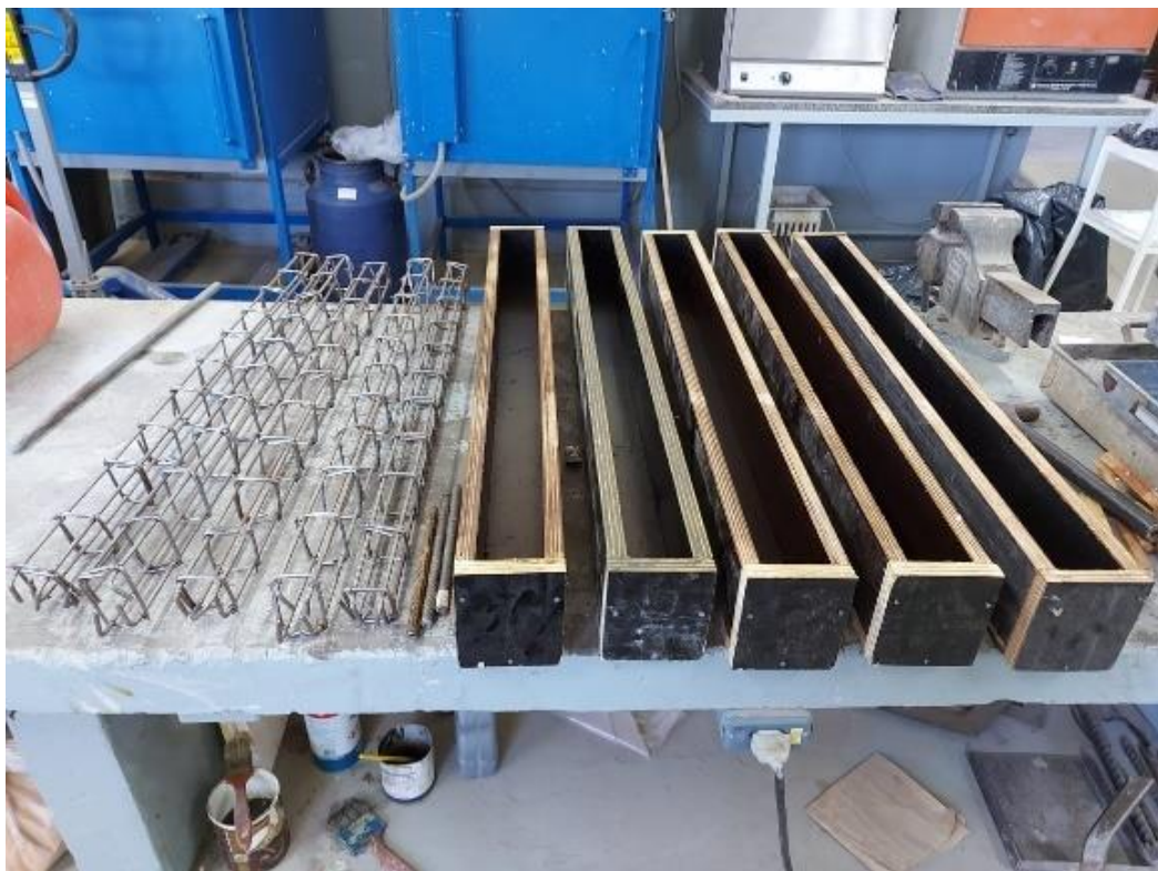
Figura 3.3: Conjunto de formas e armaduras montadas
