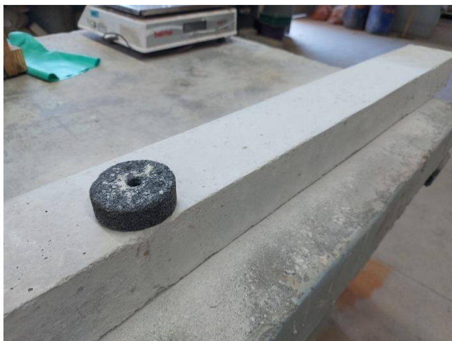
Figura 3.12: Limpeza da superfície da viga a ser reforçada com a pedra de carborundum
