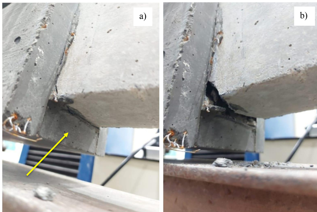
Figura 4.35: Viga V6 – Íntegra CPR a) Abertura de fissuras b) Ruptura
