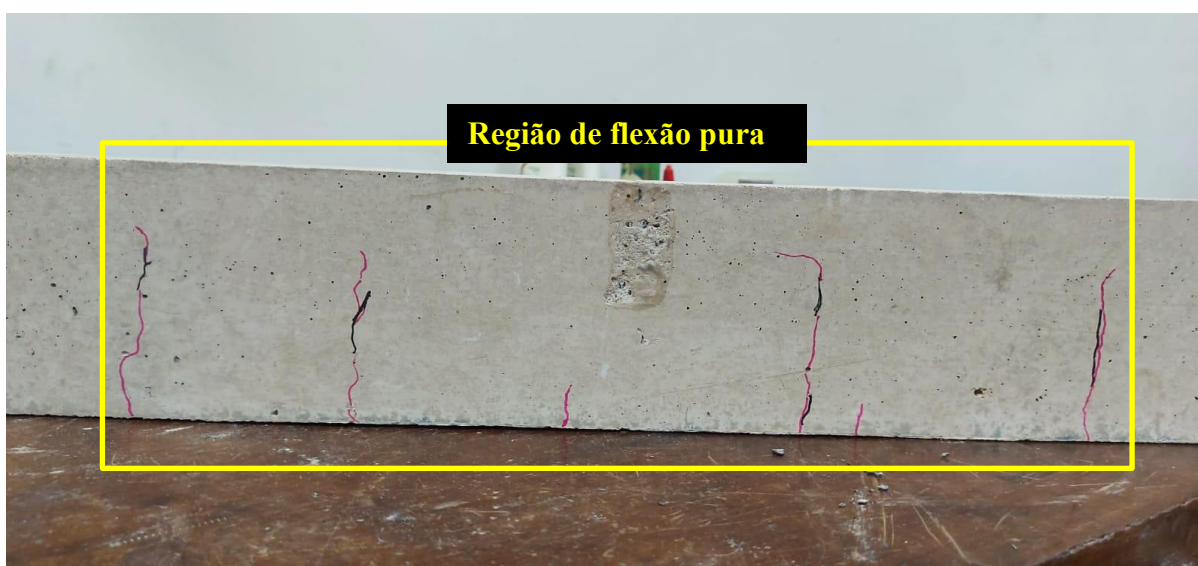
Figura 4.16: Fissuras dentro do patamar de flexão pura viga V4
