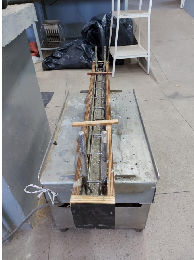
Figura 3.5: Detalhe dos tarugos posicionados para cobertura lateral
