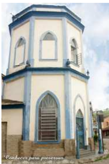
Figura 13 – Torreão de Cesário Alvim, localizado nas proximidades da Estação Ferroviária de Ubá. (Coleção Cartões Postais de Ubá) 268
