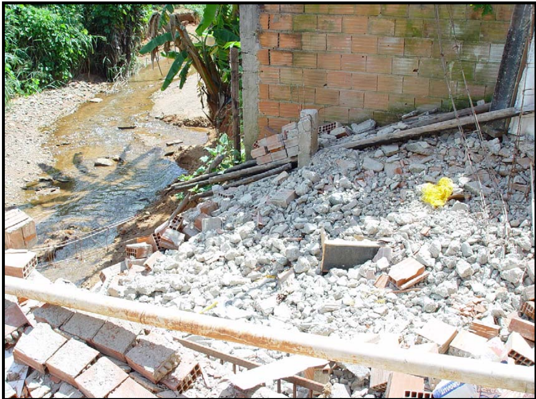
Figura 3.4 – Ruína de edificação deflagrada por movimento de massa.
