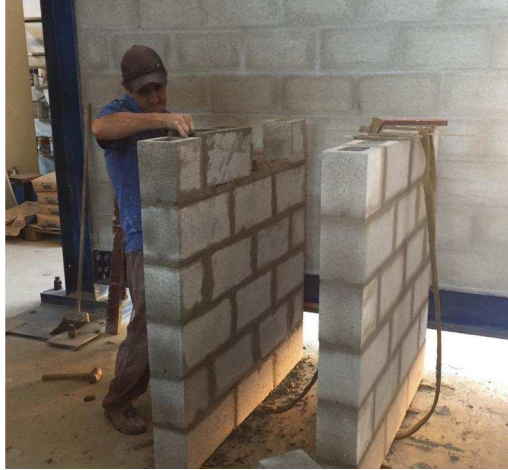
Figura 3.9 - Execução das pequenas paredes
