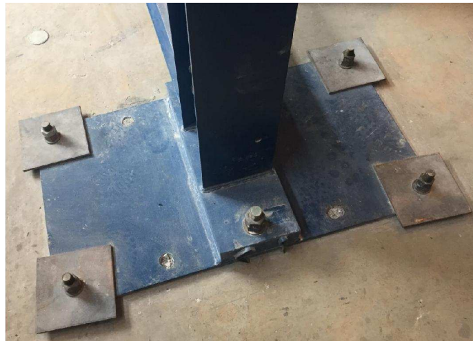
Figura 3.13 - Base dos pilares do pórtico
