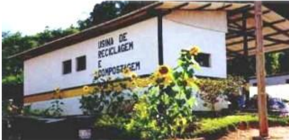
Figura 11: Unidade de triagem e compostagem de Coimbra-MG.
