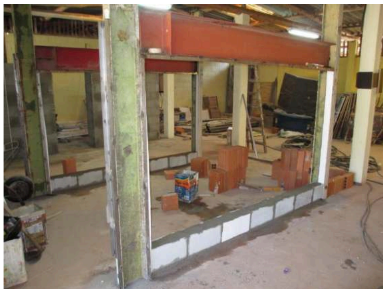
Figura 23 - Execução da primeira fiada da alvenaria do modelo experimental.
