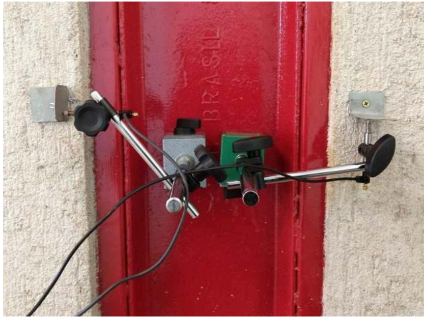
Figura 53 – Fixação dos DTs na face interna da interface 3.
