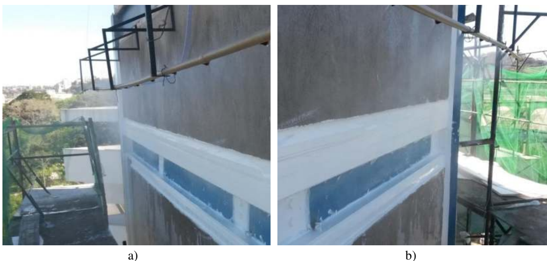
Figura 73 – Aspecto geral do ensaio de incidência de chuva em uma das fachadas Edifício do CCB-II.
