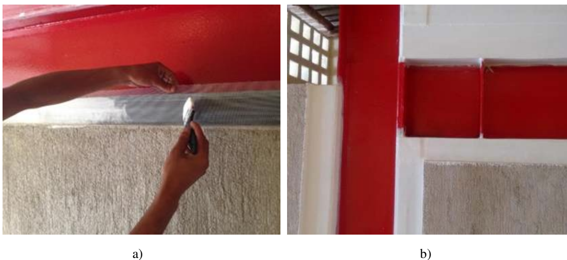
Figura 37 – Tratamento das juntas com manta de elastômero EPDM: a) aplicação da tela de poliéster com emulsão acrílica; b) aspecto final de juntas após o tratamento.
