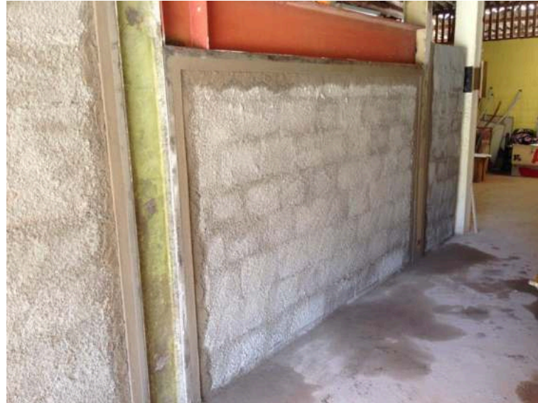
Figura 27 – Aspecto do modelo experimental após a execução do chapisco e do emboço camurçado na região das juntas.
