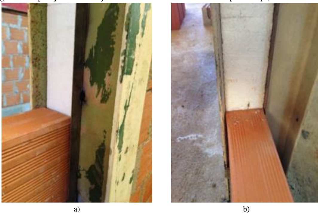
Figura 24 – Aplicação de EPS na junta JV-1 entre a alvenaria e a alma do pilar de aço, da interface INT1.
