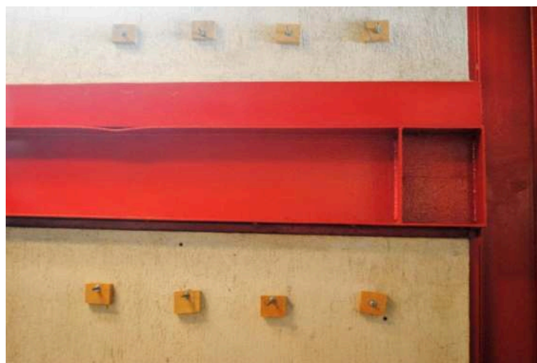
Figura 98 – Aspecto da região da interface INT2-JH1/JH3-E1 após a realização do ensaio de estanqueidade à água.
