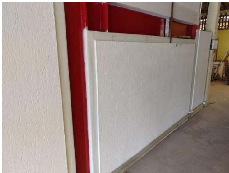
Figura 57- Aspecto geral da parede após a pintura da face externa.
