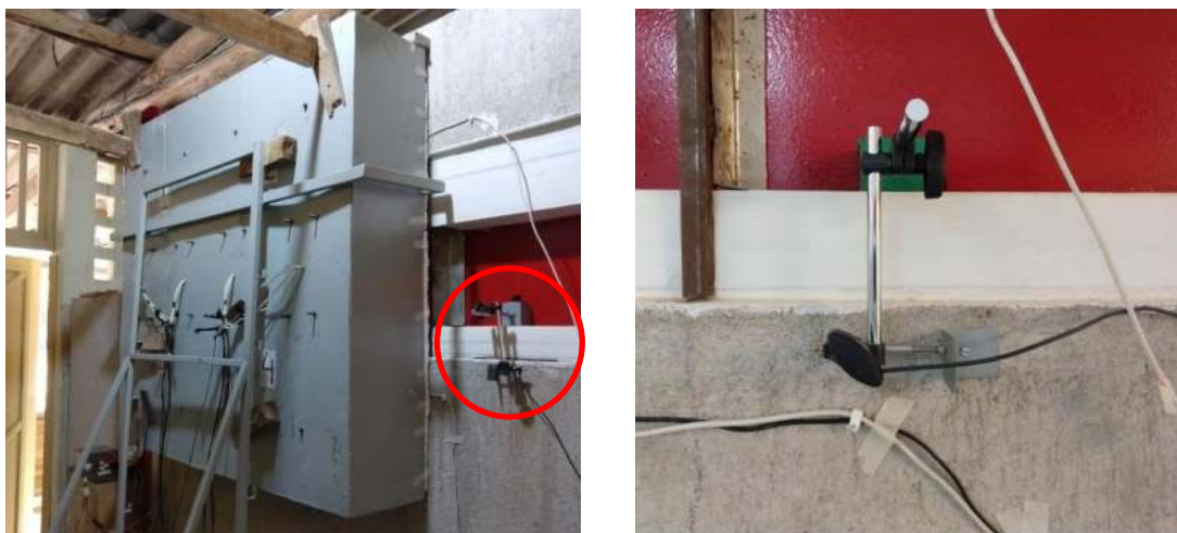
Figura 52 – Fixação do DT na face externa da interface INT2.
