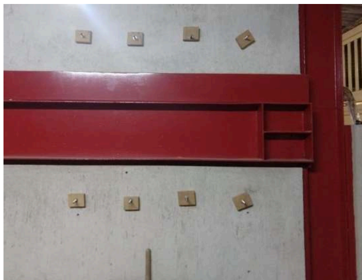
Figura 100 – Aspecto da região da interface INT2-JH1/JH3-E após a realização do ensaio de estanqueidade à água.
