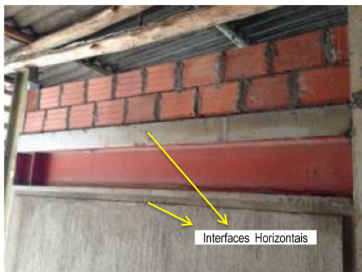
Figura 30 – Aspecto do assentamento das fiadas de alvenaria superiores.
