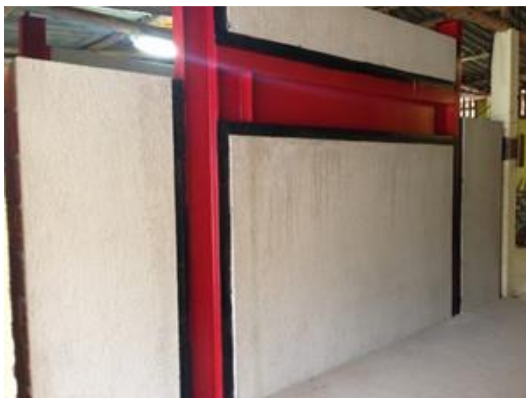
Figura 36 – Aspecto final do modelo experimental após a aplicação do tratamento com manta de elastômero EPDM.
