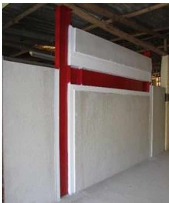
Figura 38 - Aspecto final do modelo experimental após o tratamento das juntas com manta de elastômero EPDM.
