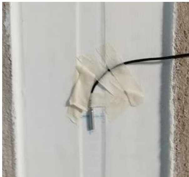
Figura 49 - Fixação de um termopar sobre a manta de elastômero EPDM aplicada em uma junta vertical.
