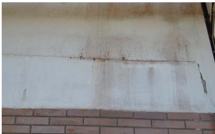
Figura 69 – Aspecto do fechamento lateral das vigas de aço após a execução na CEAD/UFV.
