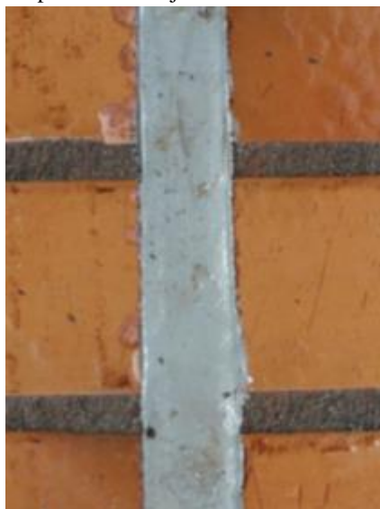
Figura 10 - Aspecto de uma junta vertical tratada com selante.
