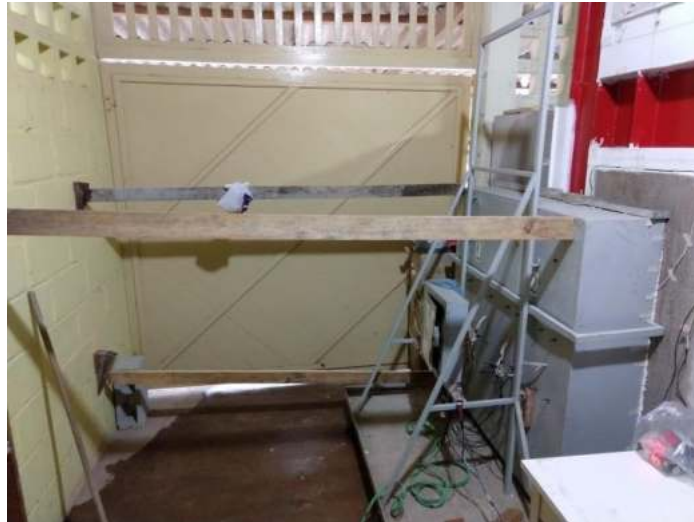
Figura 55 - Escoramento do painel radiante durante o ensaio da interface INT3.
