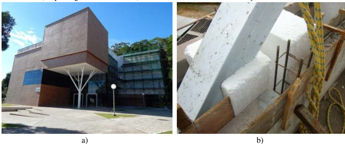
Figura 67 – Edifício CEAD/UFV: a) aspecto geral do edifício; b) detalhe do sistema de desvinculação da alvenaria.
