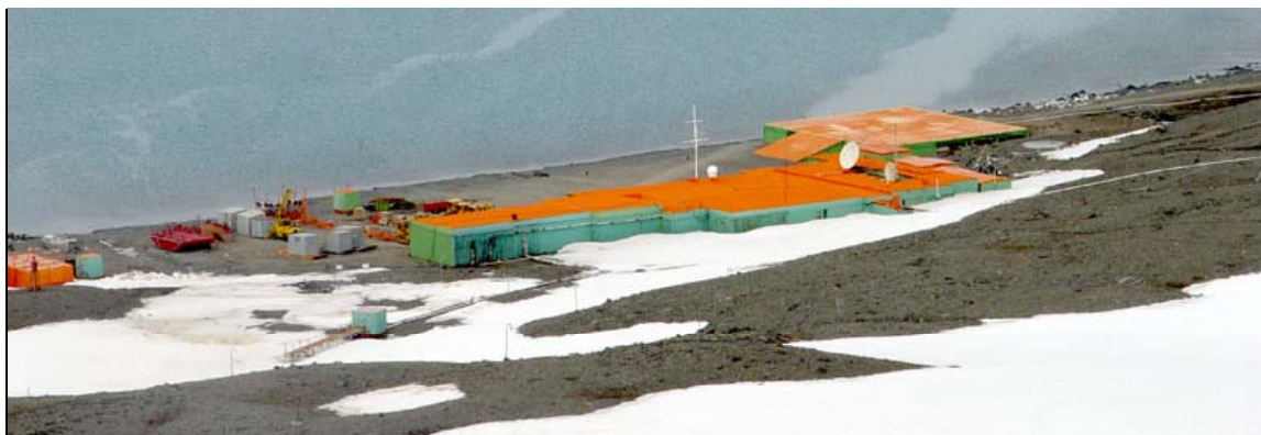
Figura 2. Manchas de óleo diesel, à esquerda, e de esgoto, à frente da EACF em 2004 (FRANCELINO, 2004).
