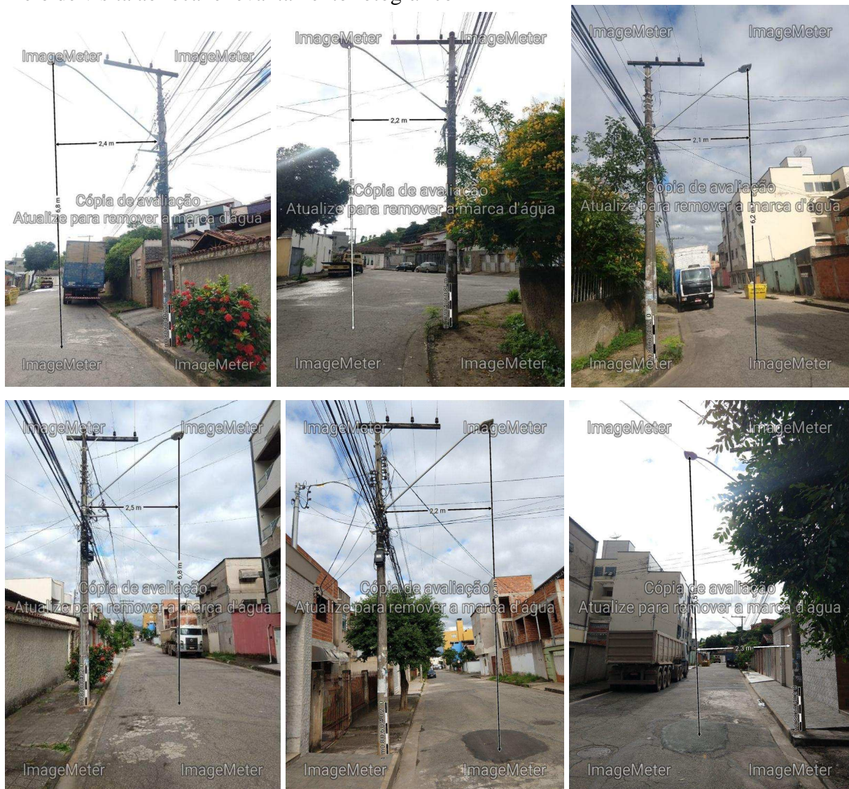
Figura 5 – Identificação da tipologia de posteamento, classificação viária e pavimentação por meio de visita ao local e levantamento fotográfico
