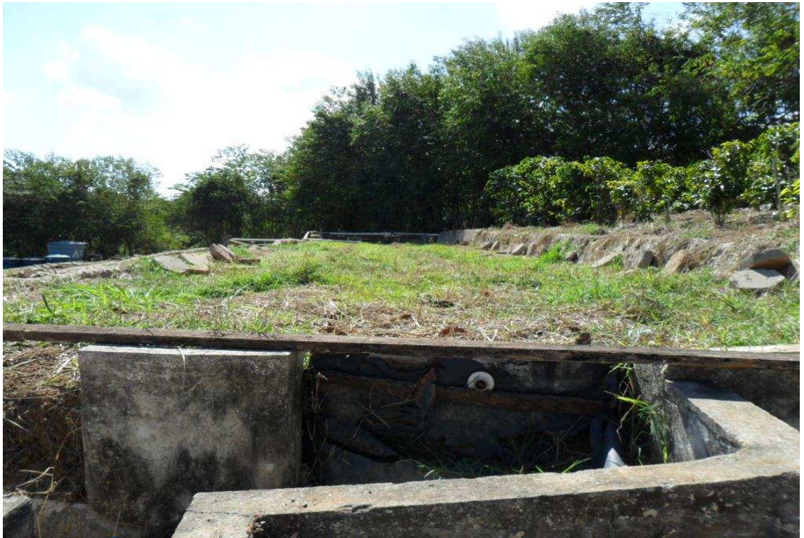
Figura 7 - Rampa de escoamento superficial para tratamento do esgoto.
