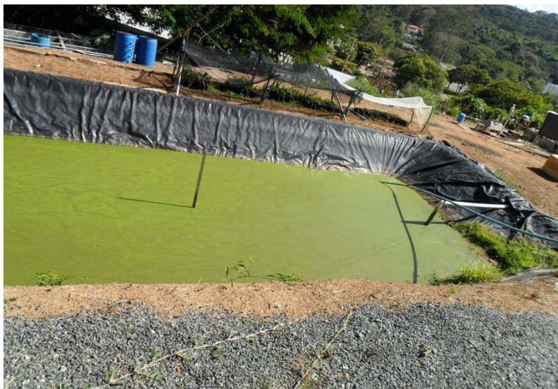
Figura 8 - Lagoa Facultativa para tratamento de esgoto.
