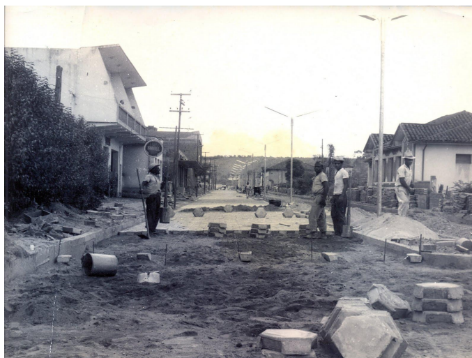
Figura 11: Calçamento da avenida P. H. Rolfs, década de 1960 169 .
