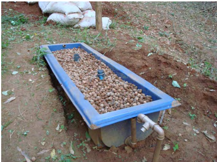
Figura 4.5: Unidade de SAC com seus coletores intermediários e bocal para instalação de torneira para amostragem.
