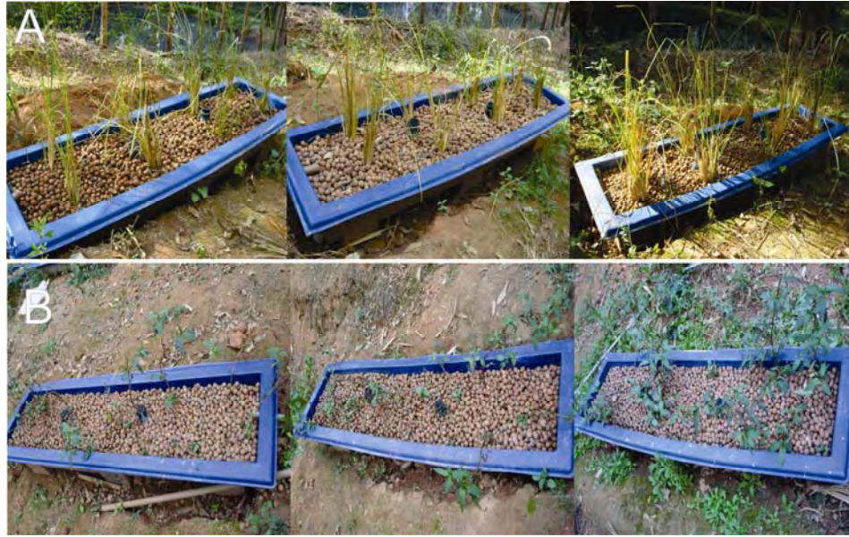
Figura 4.8: Plantio das mudas de capim vetiver no SAC V (A) e de erva de bicho no SAC E (B).
