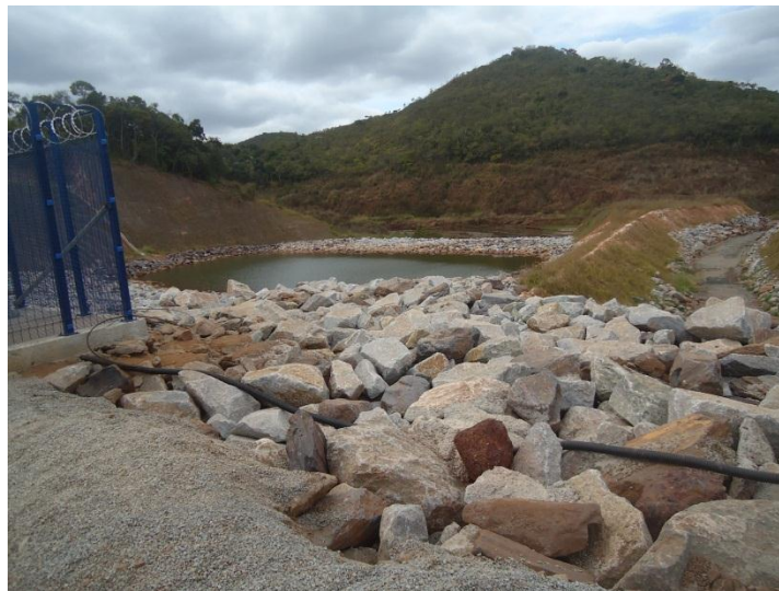
Figura 5 - Imagem de vista parcial da área do dique S4, em 22 de setembro de 2017. Fonte: Arquivo pessoal.
