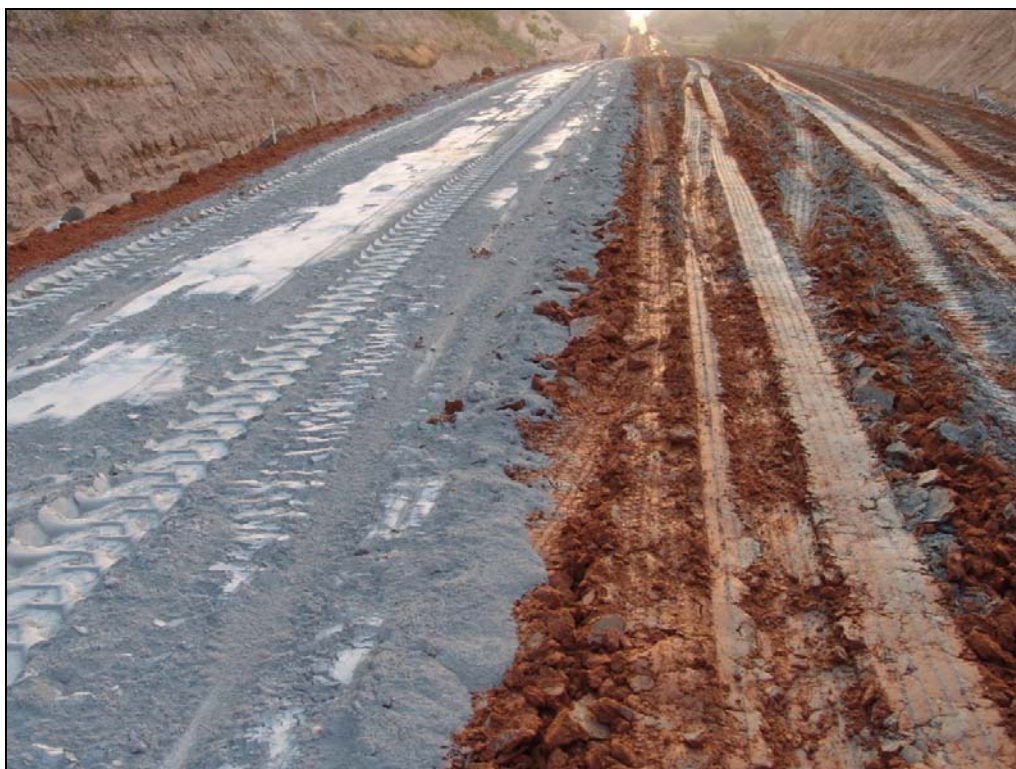
Figura 10. Uso de cimento no asfaltamento da BR-364 em substituição a rochas. Trecho entre as cidades de Manoel Urbano e Tarauacá, Estado do Acre. Foto: J.L. Lani.
