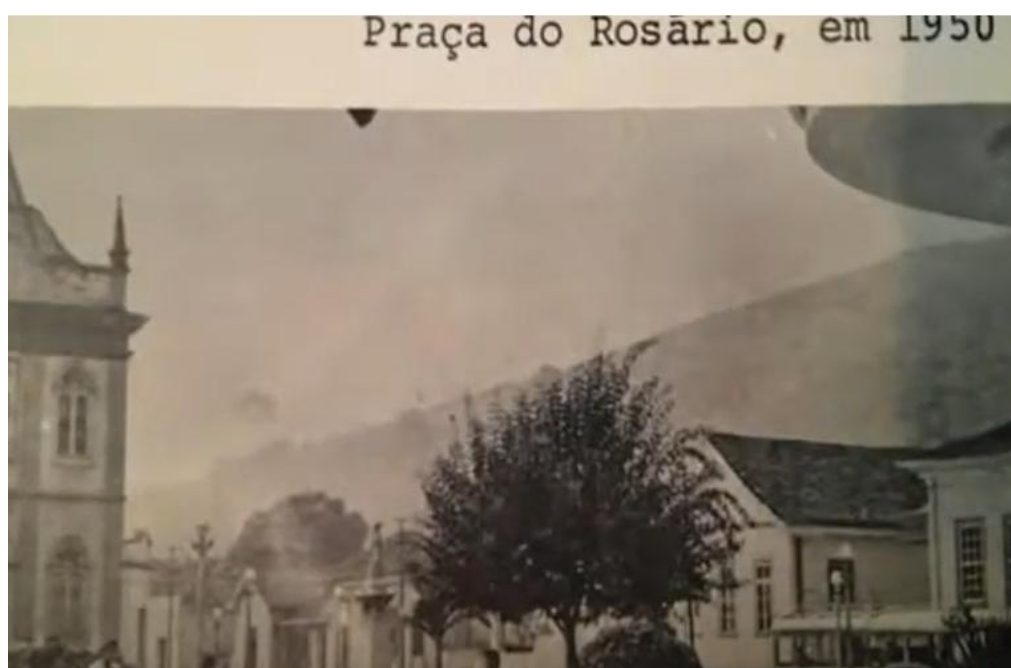
Figura 33 – Fragmento de fotografia com parte da Igreja do Rosário
