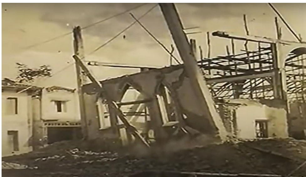
Figura 11 – Foto da demolição da Igreja
