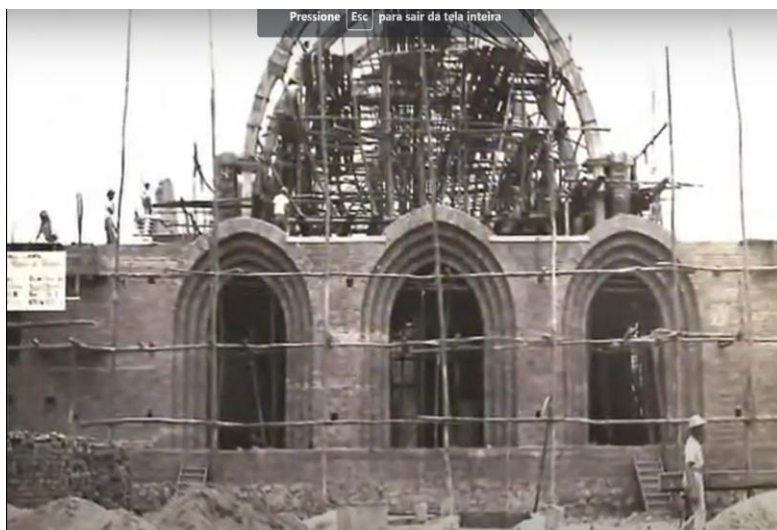
Figura 21 – Construção da Igreja Matriz
