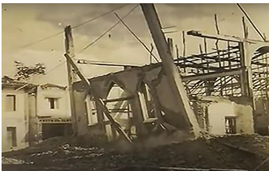
Figura 34 – Demolição da Igreja do Rosário
