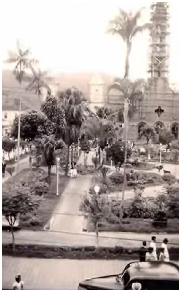
Figura 22 – Foto da construção da Matriz, e do lado, a antiga
