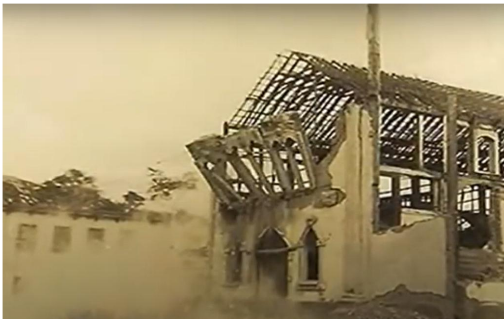
Figura 35 – Demolição da Igreja do Rosário
