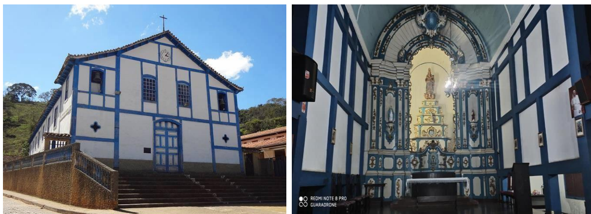
Figura 14 - Igreja de Nossa Senhora da Boa Morte
