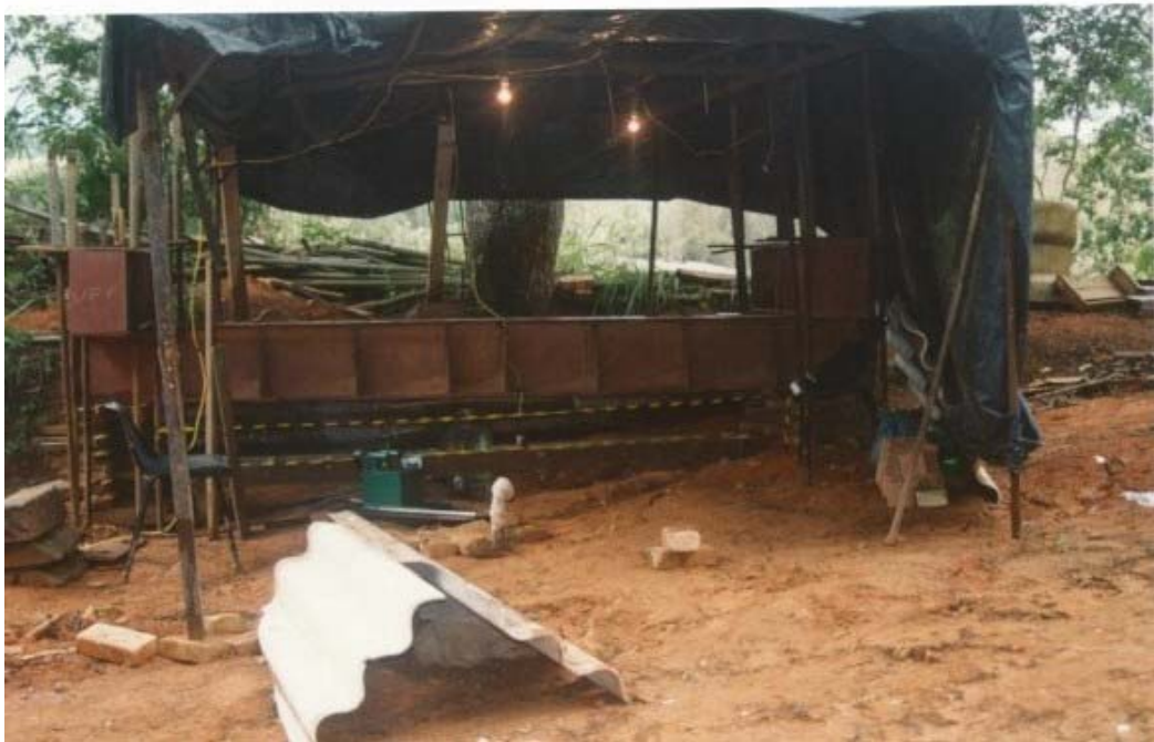
Figura 3.20 – Montagem da prova de carga – Vista 03
