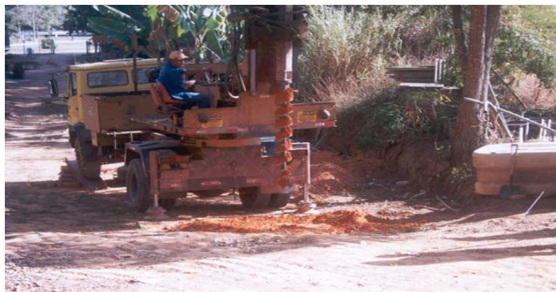
Figura 3.8 – Início da escavação da estaca
