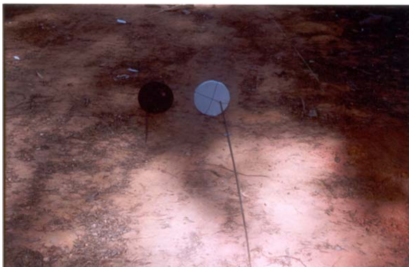
Figura 3.6 – Vista da montagem das chapas de aço
