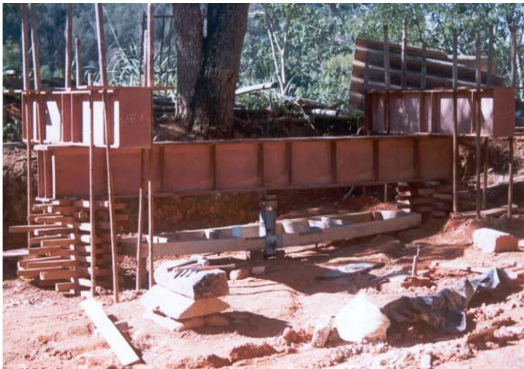
Figura 3.18 – Montagem da prova de carga – Vista 01
