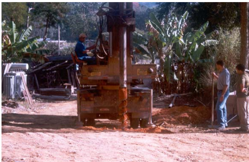
Figura 3.9 – Escavação da estaca com trado mecânico – Vista 01
