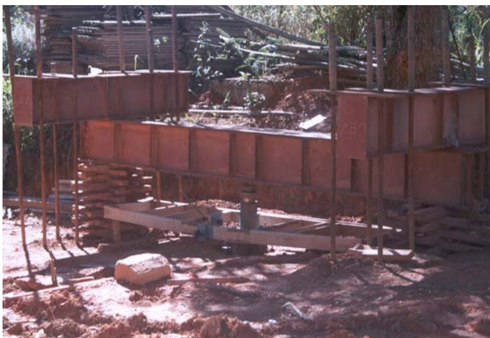
Figura 3.16 – viga de referência em madeira – Vista 01
