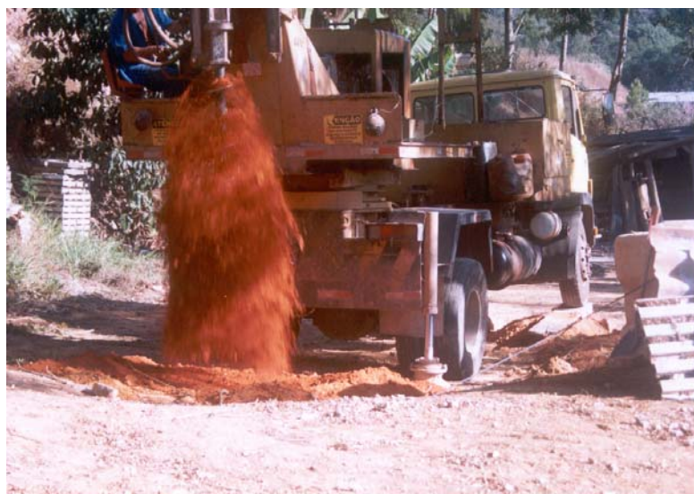
Figura 3.10 – Escavação da estaca com trado mecânico – Vista 02
