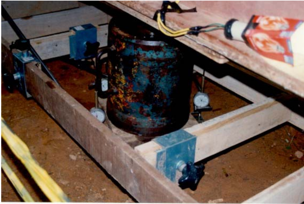
Figura 3.19 – Detalhe da montagem com macaco hidráulico nº 2 – (2000 kN) – Vista 02
