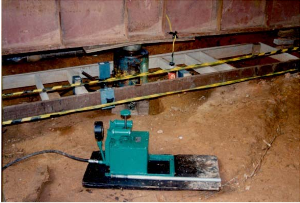
Figura 3.12 – Montagem do conjunto utilizando macaco hidráulico nº 2
