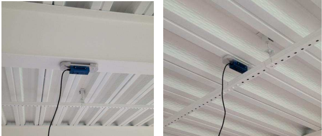
Figura 3-2 – Exemplo de fixação do acelerômetro GP2Lx USB em estrutura metálica através da base magnética.
