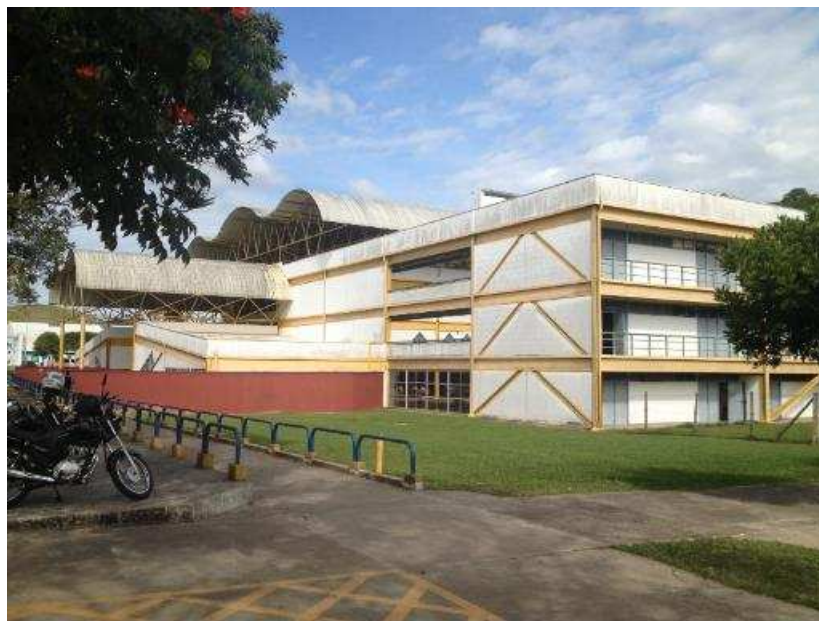
Figura 4-1 – Aspecto geral do Edifício do PVB da UFV.
