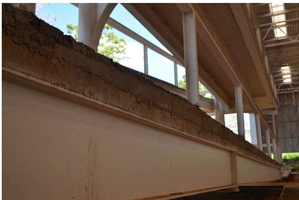
Figura 4-40 - Patamar executado com enchimento de concreto na zona do ponto P02 da rampa de acesso.
