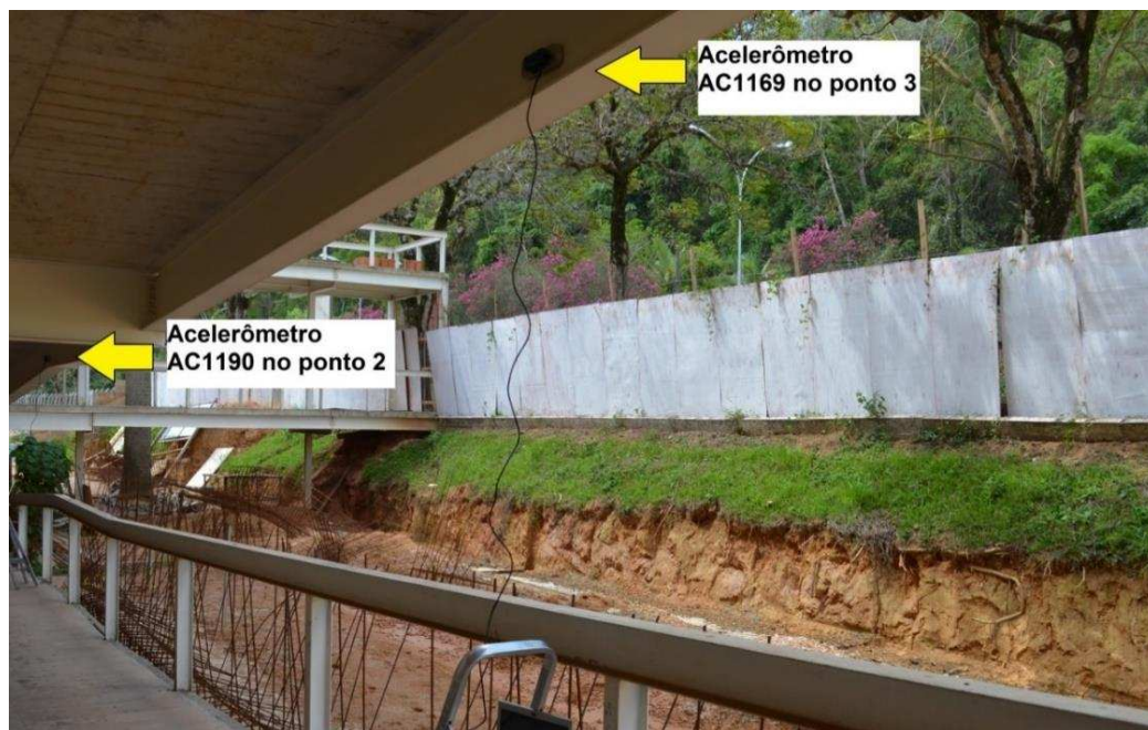
Figura 4-29 – Posicionamento dos acelerômetros nos pontos P02 e P03 da rampa de acesso.
