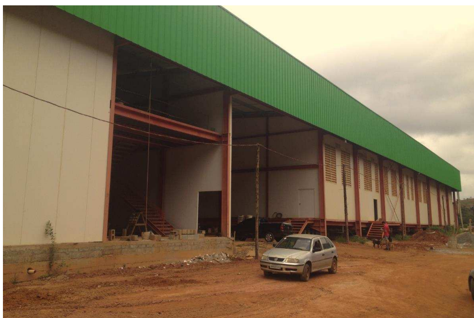
Figura 4-47- Aspecto geral do Novo Laticínios FUNARBE.
