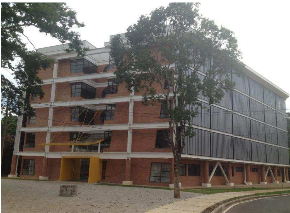
Figura 4-61- Aspecto geral do Edifício das Licenciaturas da UFV.
