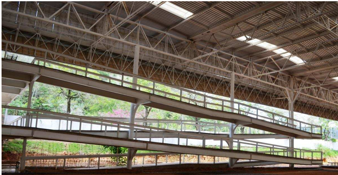
Figura 4-26 - Vista geral da rampa de acesso.
