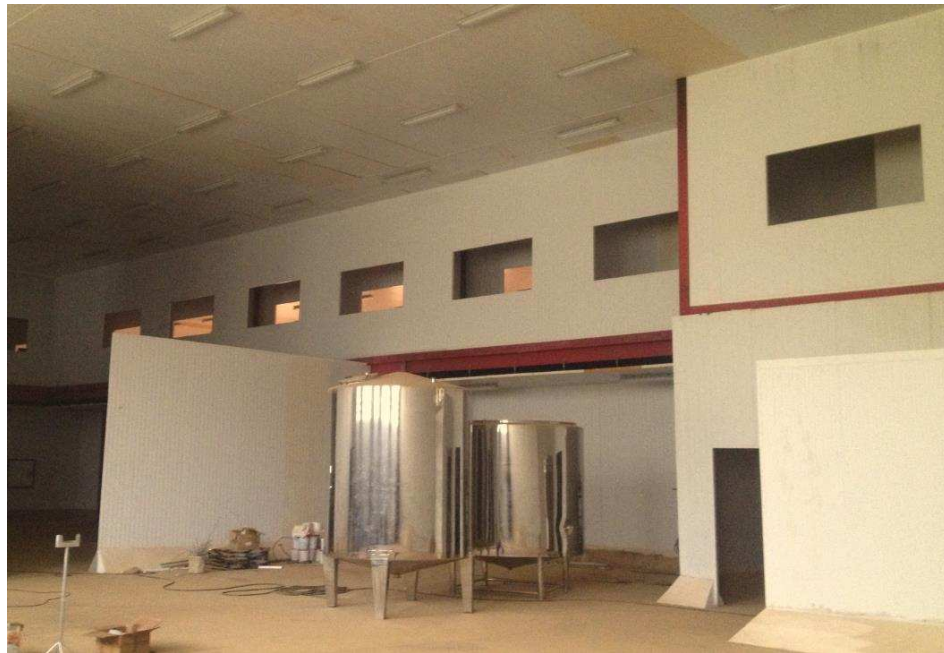
Figura 4-49- vista lateral esquerda da passarela.
