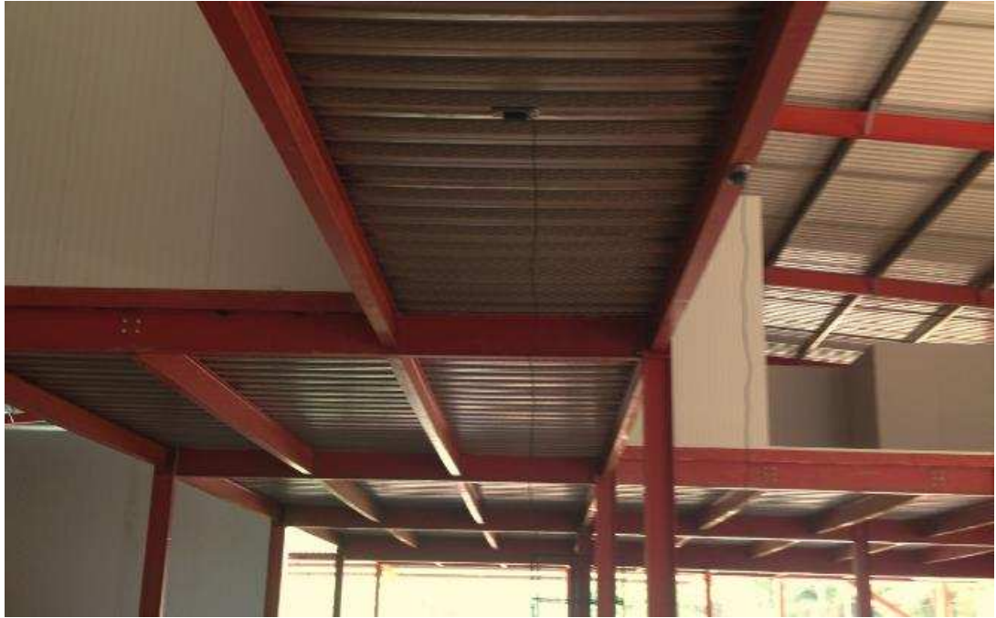
Figura 4-53- Apoio elástico do terceiro trecho da passarela e posicionamento do acelerômetro AC 1190 no ponto P01.
