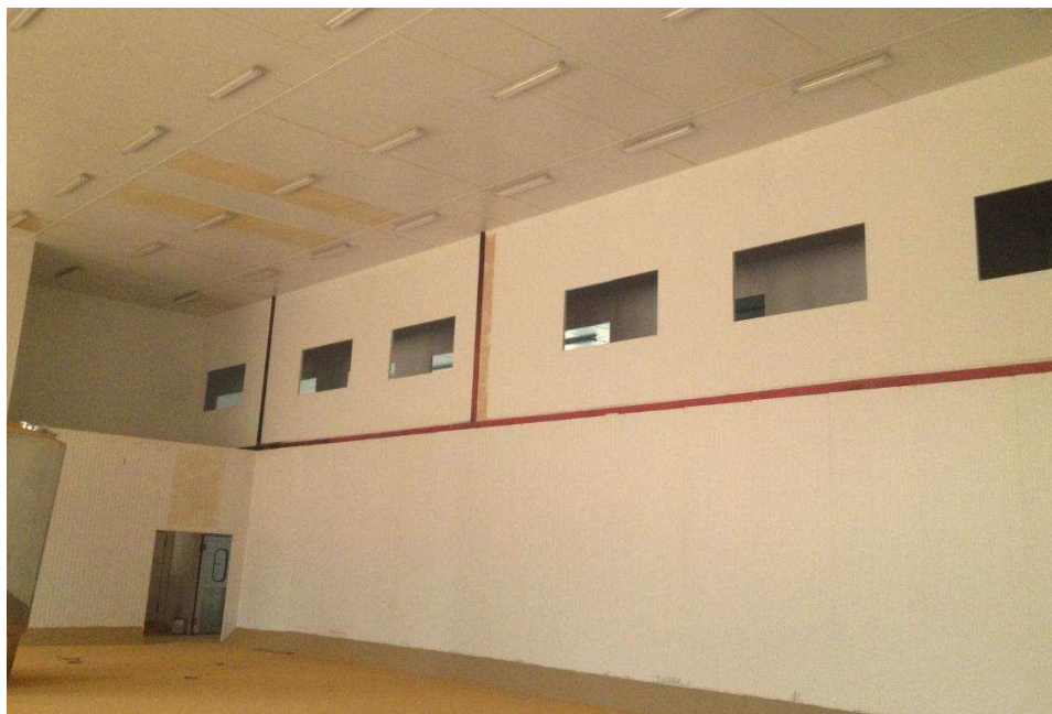
Figura 4-50- Vista lateral direita da passarela.
