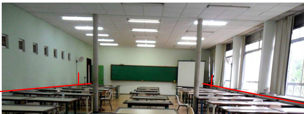
Figura 13 – Tubulação de tomadas e interruptores (em vermelho) Fonte: Acervo da autora, 2015
