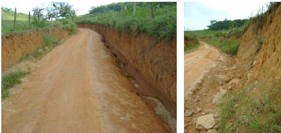
Figura 04: Trechos da estrada vicinal VCS 296 encaixados no terreno natural
