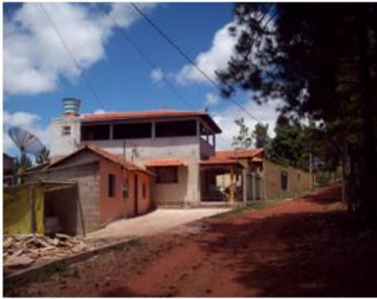
Figura 85 – Edificações com qualidades artísticas comprometidas. Fonte: Rafaele Bogatzky R. Corrêa, 2011.
