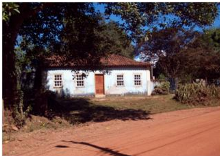
Figura 73 – A chegada em Guinda – “edifício-barreira”. Fonte: Rafaele Bogatzky R. Corrêa, 2012.
